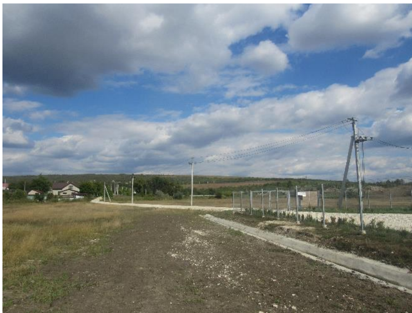
Figura 79. Linia electrică din apropierea terenului indicat
