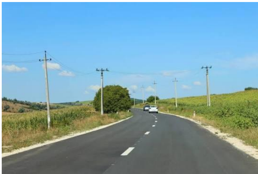
Figura 16. Imagine reprezentativă a traseului și stării drumului pe ruta R2
