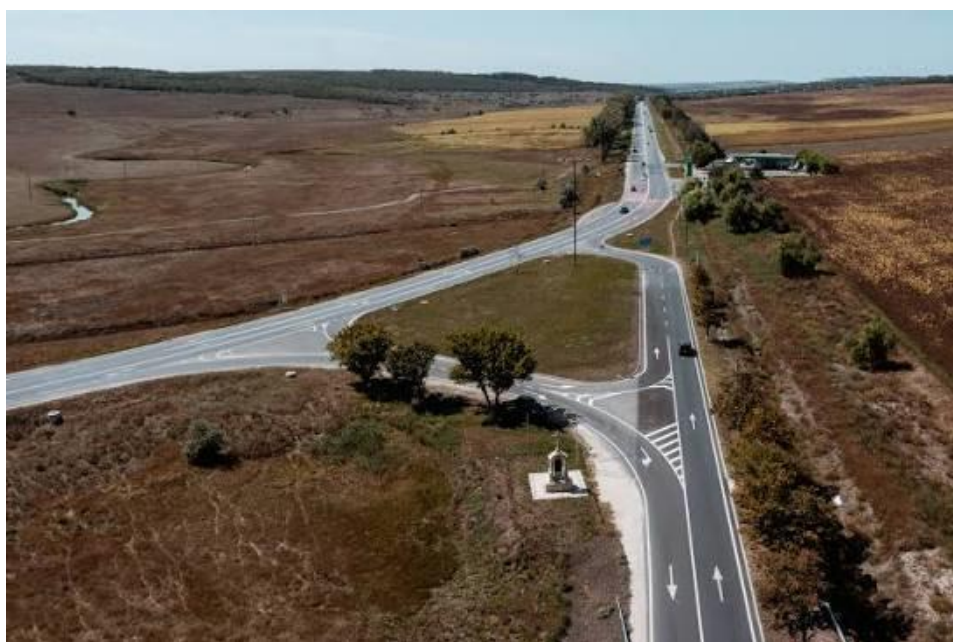
Figura 19. Imagine reprezentativă a traseului și stării drumului pe ruta R4
