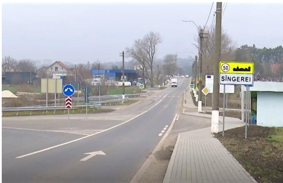
Figura 15. Imagine reprezentativă a traseului și stării drumului pe ruta R1
