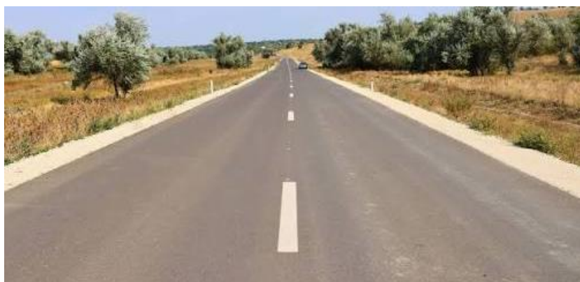
Figura 18. Imagine reprezentativă a traseului și stării drumului pe ruta R3
